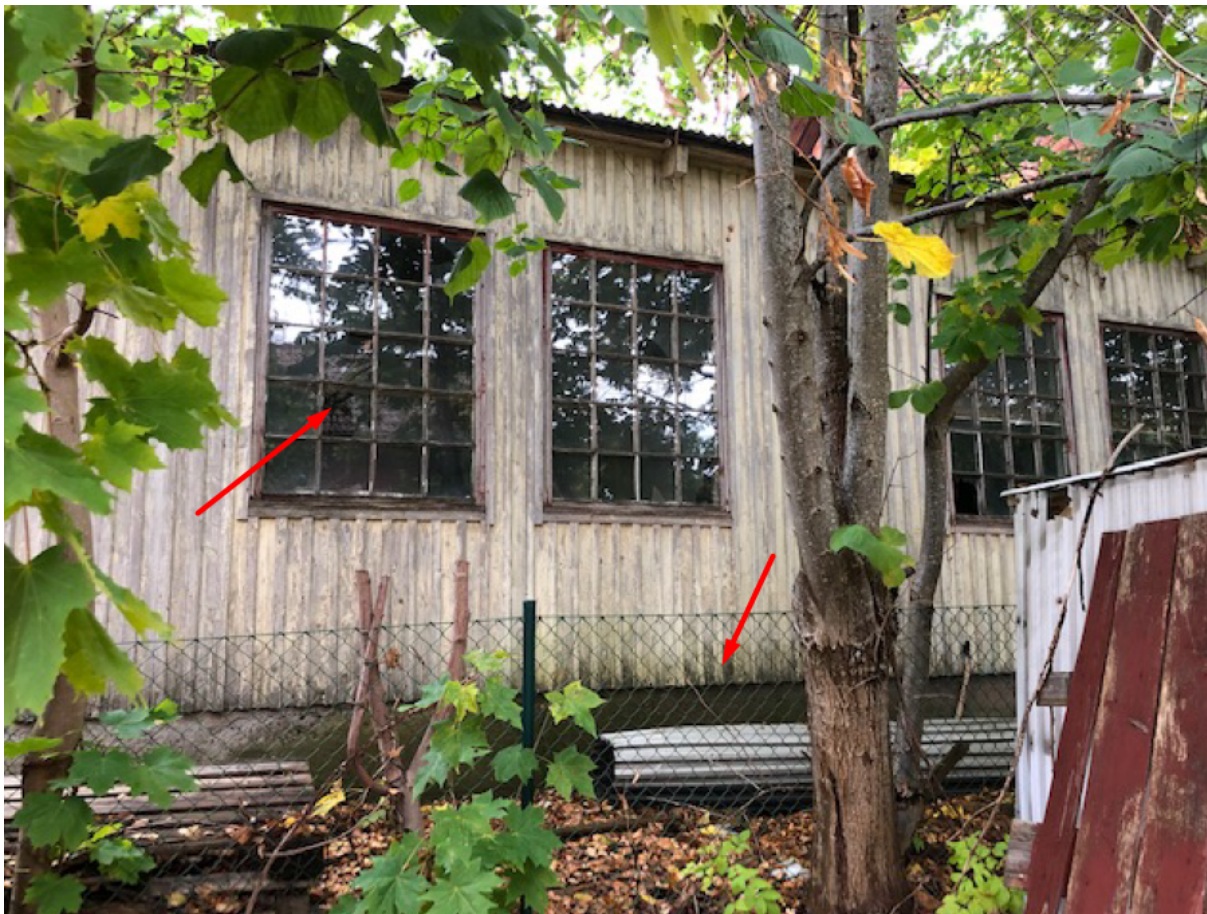
Trasiga fönster. Fuktangrepp i fasad. Takplåt som ligger efter marken.
