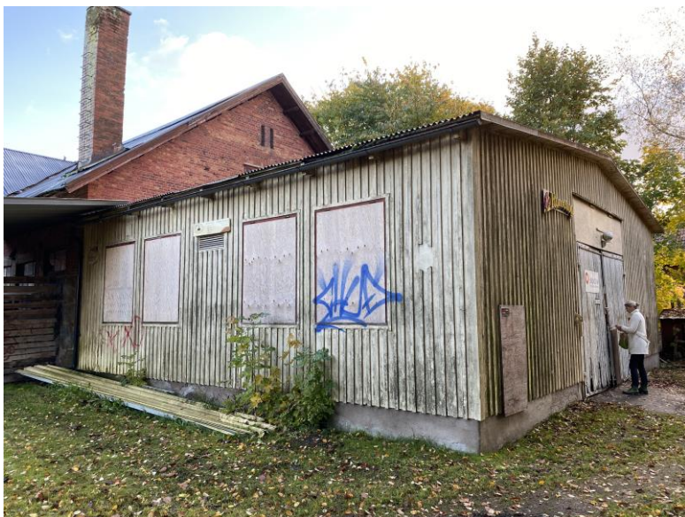
Stalltillbyggnad med fasad av locklistpanel samt tak belagt med korrugerad plåt.
