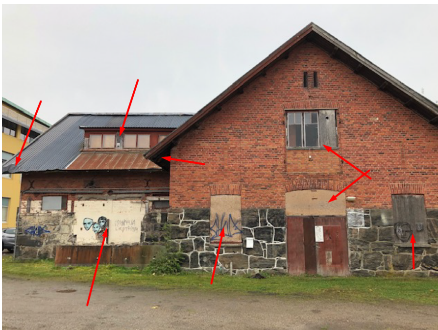
Igensatta fönster, skada i takplåt, eftersatt underhåll av fasadpanel vid och mellan fönster på våning 2.
