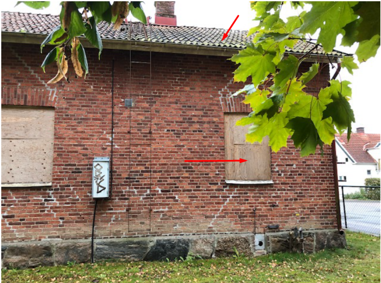
Baksidan av bostadshuset har igensatt fönster med plywood och fasadskador. Påväxt på taktegel.
