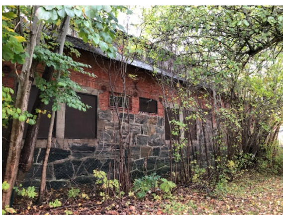
Igensatta fönster, ventil som saknas. Växtlighet inpå fasad. Fasadskador där tegel släppt vittrat, markant synligt ovanför den trasiga ventilen.
