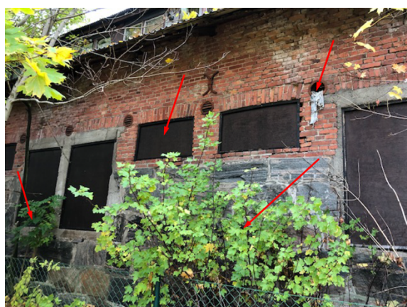
Igensatta fönster, ventil som saknas. Växtlighet inpå fasad. Fasadskador där tegel släppt vittrat, markant synligt ovanför den trasiga ventilen.
