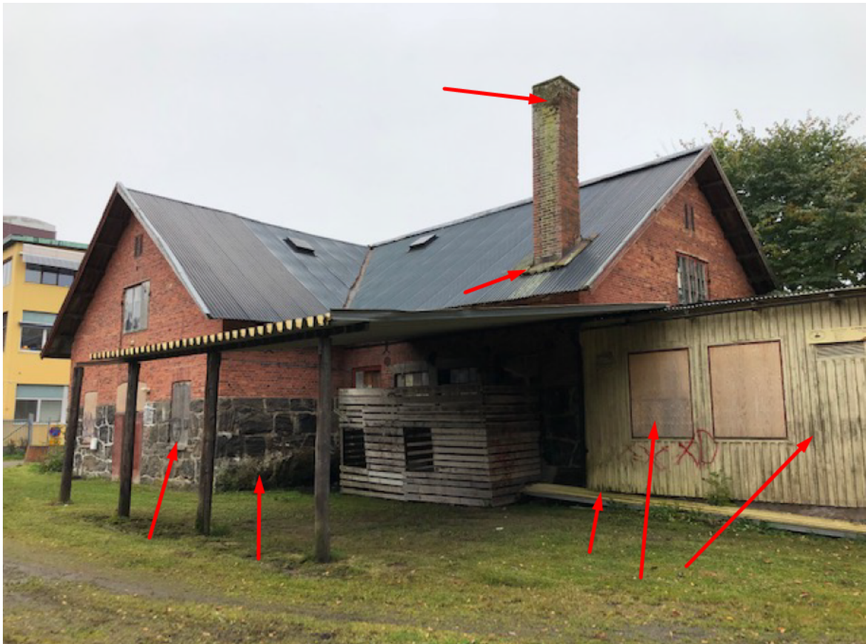
Skorstenen har eftersatt underhåll samt påverkan i konstruktion redan från takplaceringen. Eftersatt underhåll i träfasad med synliga fuktangrepp. Algpåväxt i granitgrund. Igensatta fönster.
