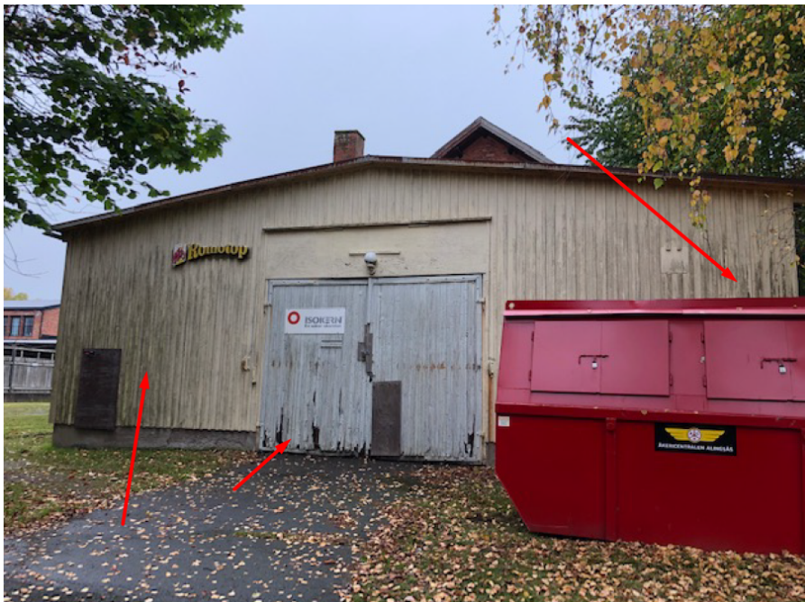
Eftersatt fasadunderhåll. Trasiga portar.
