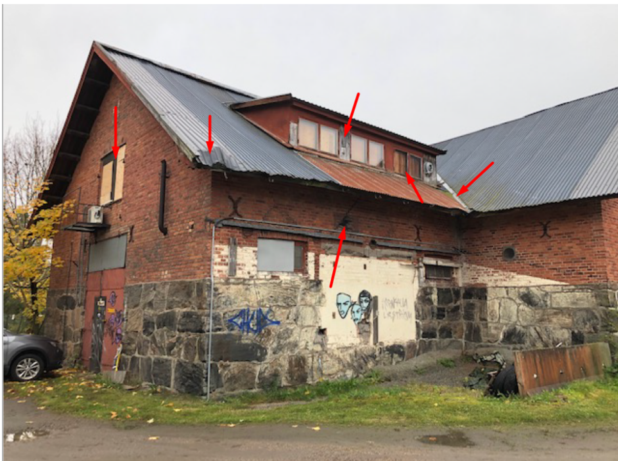
Skada i tegelfasad där tidigare utsmyckning troligen varit infäst. Mosspåväxt på tak.
