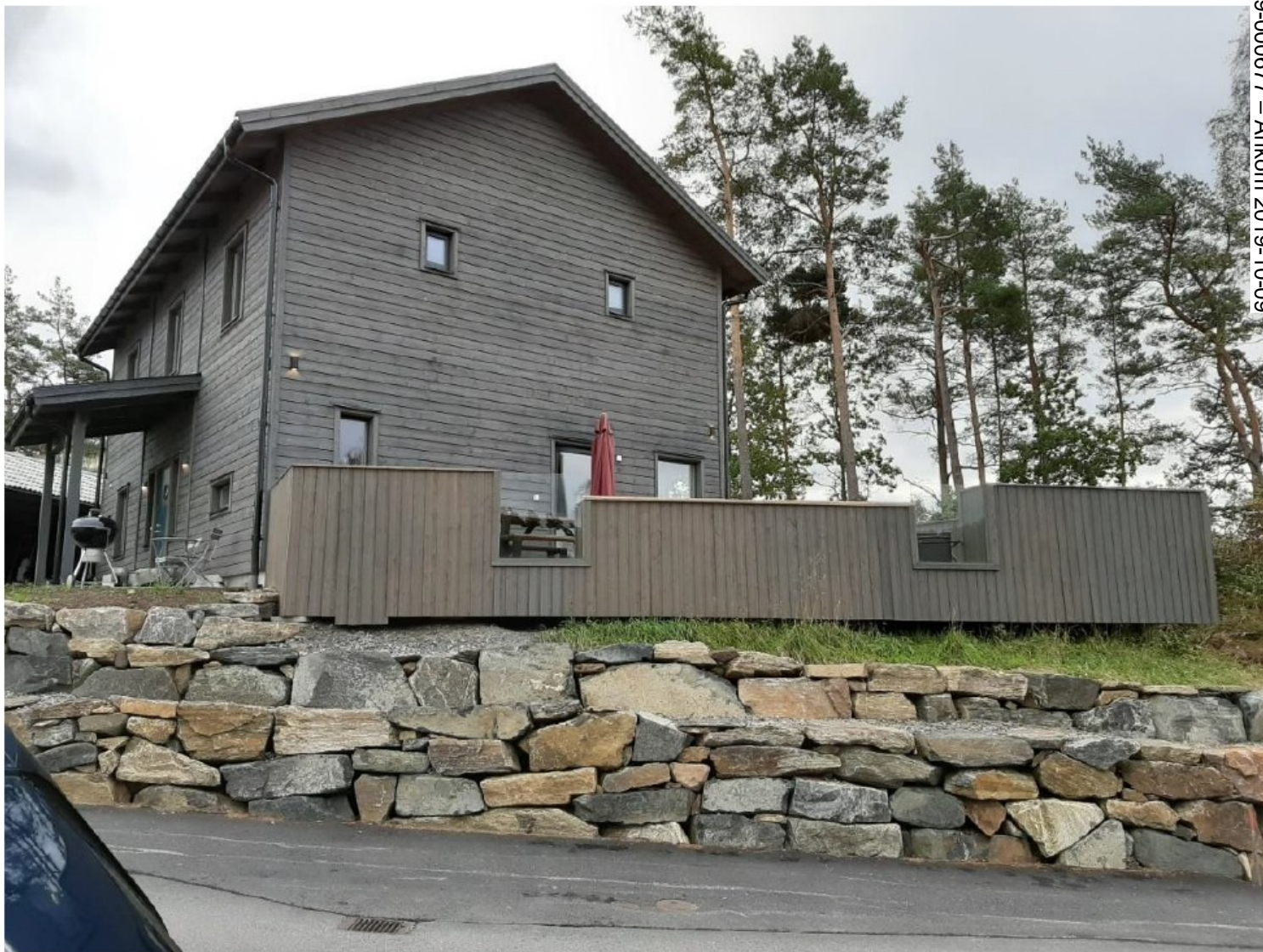
Ormekullen 9 Hus m stödmur och altan 2019-10-03
