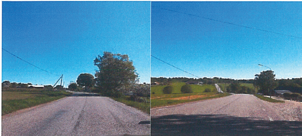
Bild 5 och 6. Vyer av vägen mellan Långared och Looviken som är smal och kurvig
