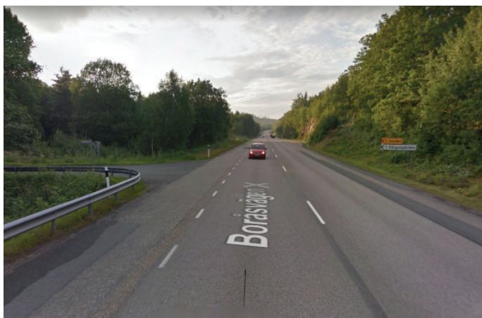
Korsningen lv 180/Färgesundsvägen
