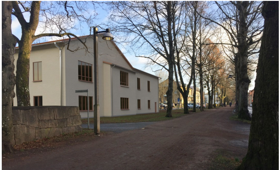
Nybyggnaden mot Norra Ringgatan
