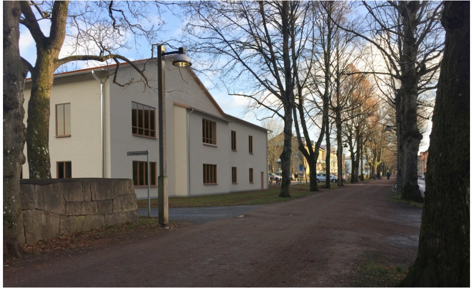
Nybyggnaden mot Norra Ringgatan
