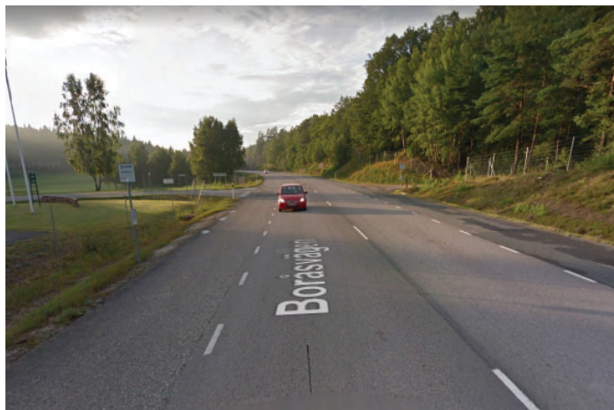
Korsningen lv 180/Svanviksvägen
