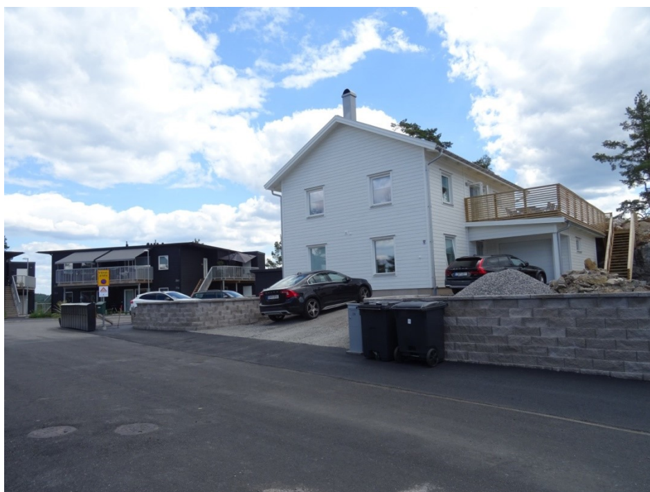
Ormekullen 12, ulovlig oppsætning av mur
