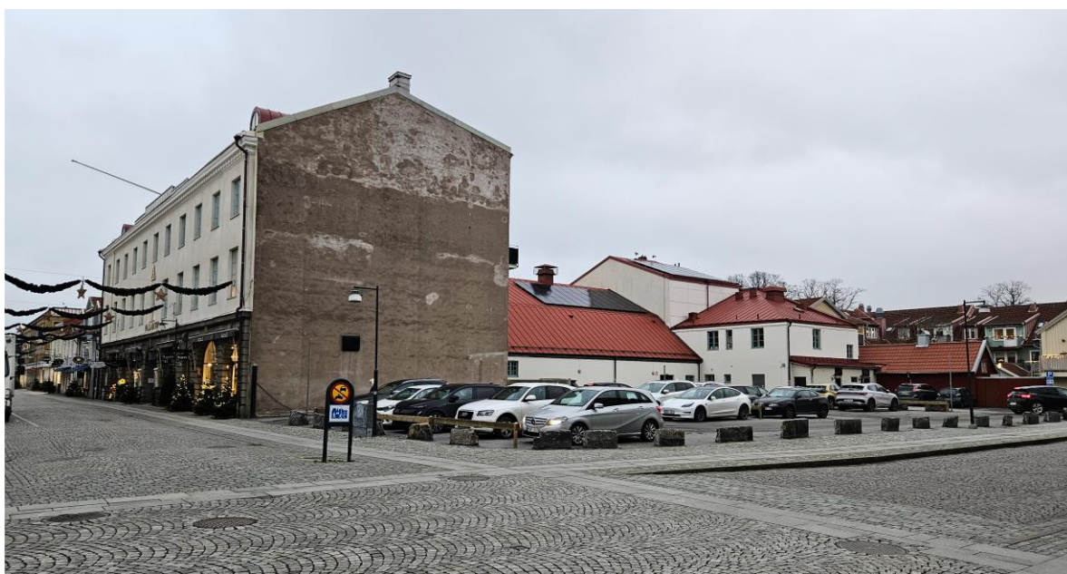
Figur 7. Planområdet med parkeringsplatser sett från korsning Nygatan-Norra Strömgatan. Gaveln på Palladiumhuset. Foto Norconsult.
