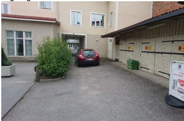
Förråden till höger ska rivas och ersättas av Hus 3
