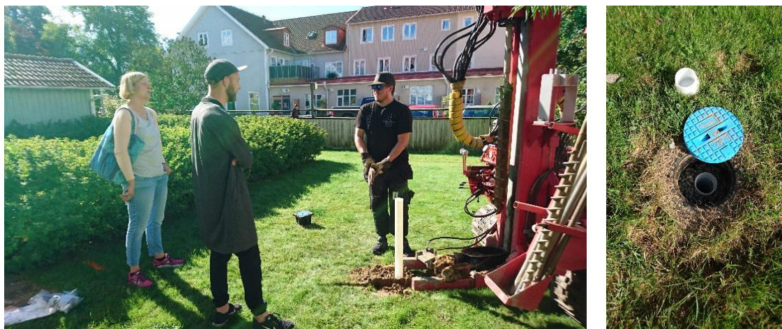
Figur 7. Provpunkt Hj2. Jordprovtagning och installation av grundvattenrör.
