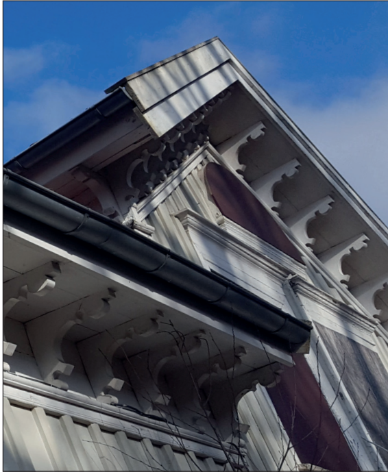
Figur 22 Takgesimsens konsoler upp mot takfoten är värda att ta vara på för återbruk på byggnad från samma tid. Foto: Alingsås kommun 2024-03-04.
