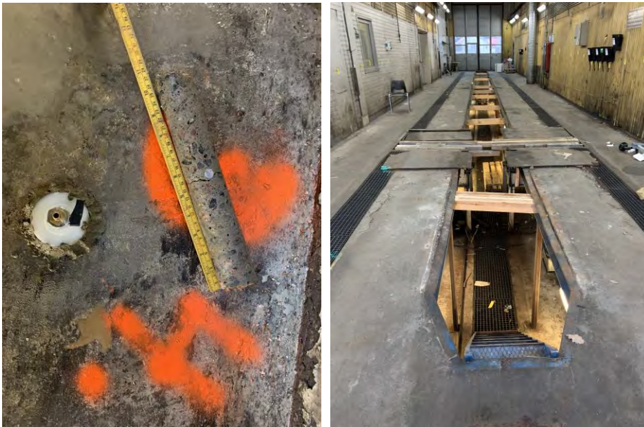
Figur 6 Foton från kärnboringen i aktuell byggnad. Bild till vänster visar provpunkt PG2304 och bild till höger visar oljegrop (2 m djup grop genom hela byggnaden). Foton från Sweco.
