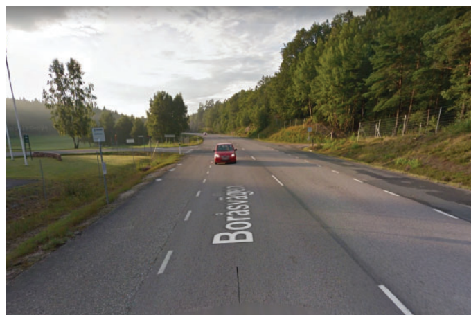
Korsningen lv 180/Svanviksvägen
