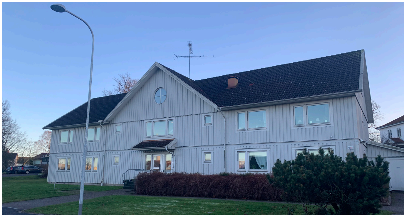
Flerbostadshuset på aktuell fastighet. Foto: Alingsås kommun
