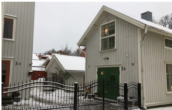
Fastigheten från Färgaregatan, magasinbyggnad till höger
