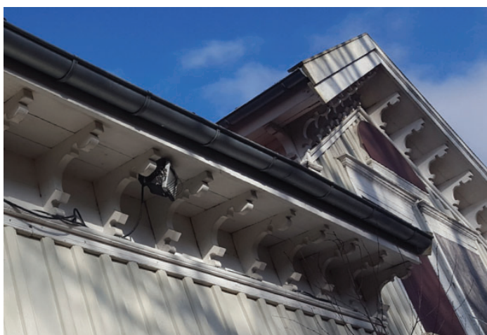
Tackonsolens konsoler upp mot takfoten och snickerier vid entrén är värda att ta vara på för återbruk på byggnad från samma tid.
