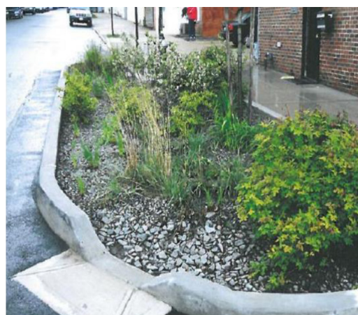
Exempel på biofilteranläggningar (Sweco 2023).
