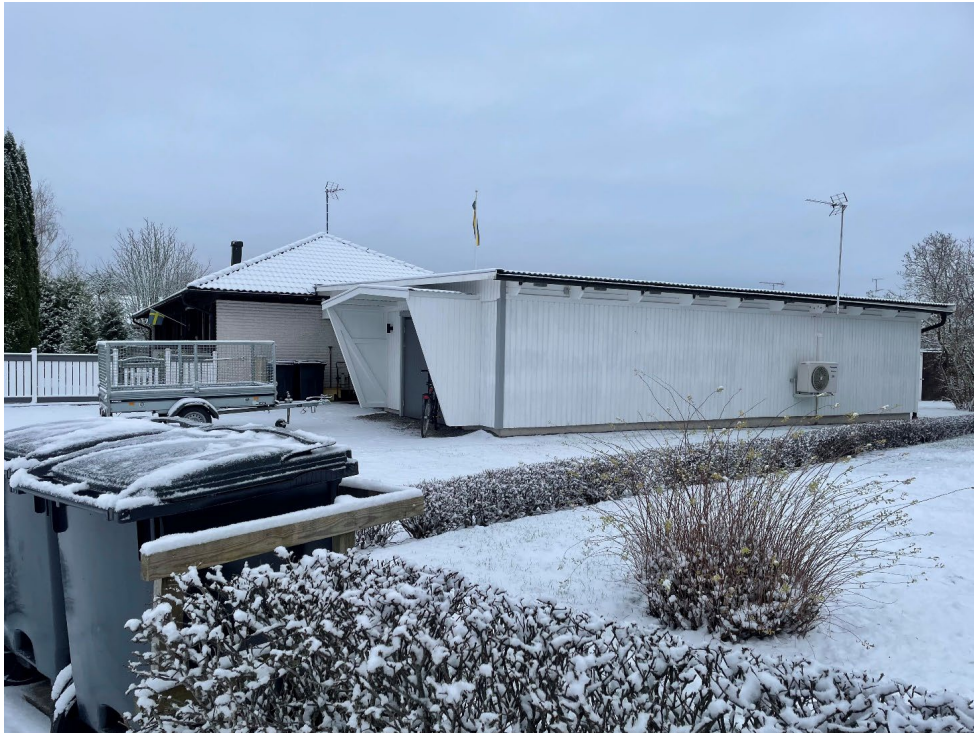
Bebyggelse inom fastigheten med garage i framkant
