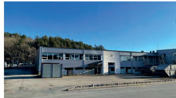
Befintlig byggnad på tomten
