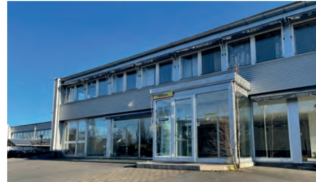
Befintlig byggnad på tomten
