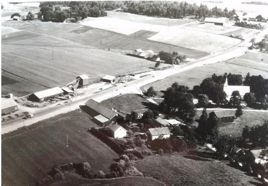
Figur 31. Flygfoto från 1950 där delar av sågverket med upplag syns i bakgrunden och Bälinge kyrka med gårdar i förgrunden.
