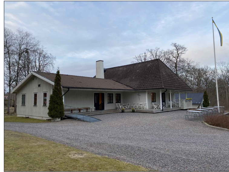
FASADER MOT SYDVÄST
