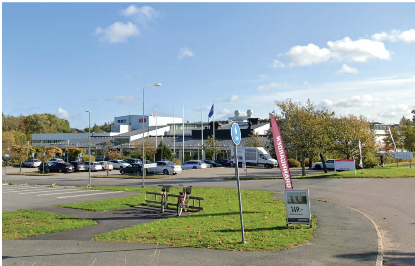
Befintlig industribyggnad inom planområdet, sett från korsningen Sävelundsgatan-Pumpgatan (Google Maps)
