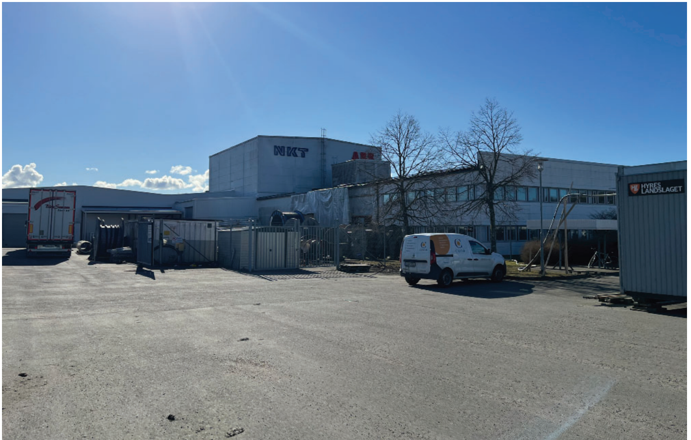
Befintlig industribyggnad inom planområdet, sett från nordväst
