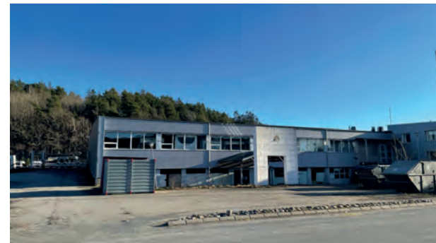
Befintlig byggnad på tomten
