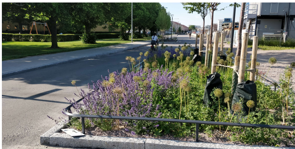
Figur 19 Exempel på biofilter/ skelettjord för träd i gatumiljö.
