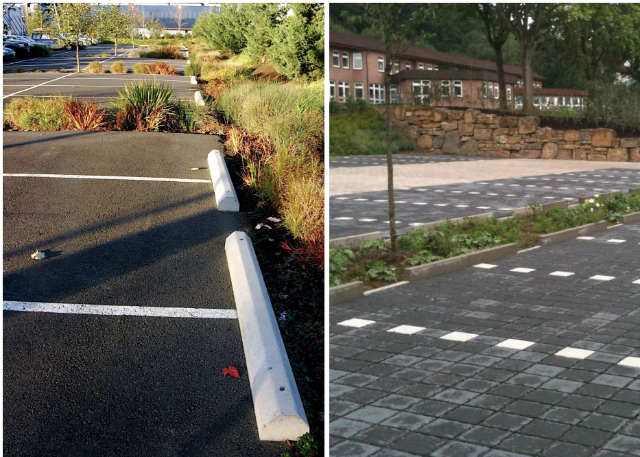
Figur 17 Exempel på biofilter längs med parkeringsplats.
