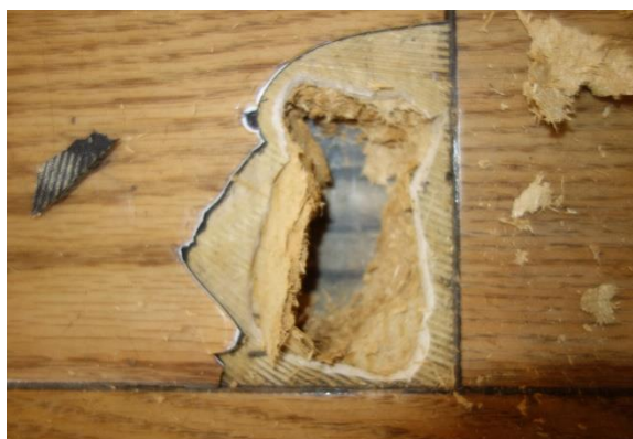
Figur 26. Exempel på lagerföljd av ytskikt på bottenplan (prov 26). Ny PVC, ny linoleum, masonit, röd/grå strimmig plattmatta m ljust lim, masonit, träbjälklag. Inget lager innehåller asbest.
