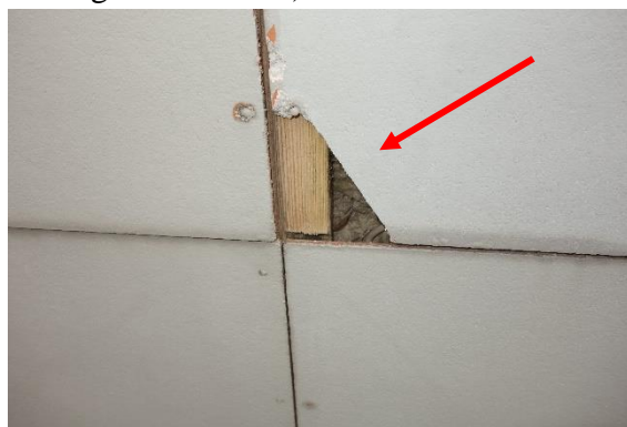
Figur 5. Närbild fasadskiva av eternit spikad på otryckt regelverk och mineralullsisolering.
