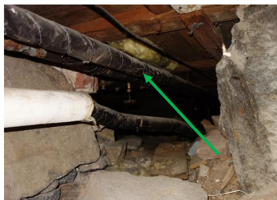
Figur 49. Prov 1 Svart klet på rör runt papp innehåller inte asbest enligt analys.
