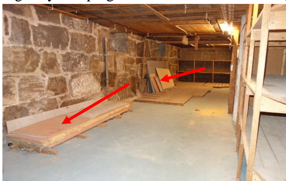
Figur 10. Grundmur av storsten, bottenplatta av betong och golvbjälklag till bottenplan av trä.
