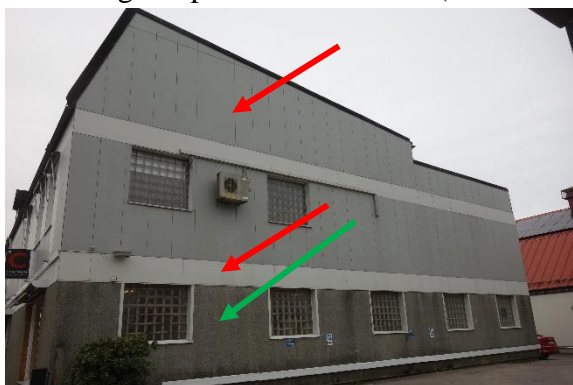
Figur 4. Fasaderna är klädda med eternitskivor (röda pilar) och steniskivor (grön pil), spikade på otryckt regelverk och mineralull utanför den ursprungliga putsade tegelfasaden.
