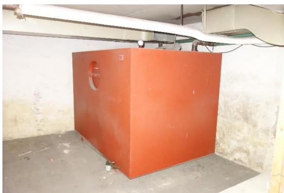
Figur 38. Oljecistern som ska tömmas och rengöras innan skrotning.
