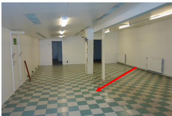
Figur 22. Grön/vit plattmatta i originaldelen på vindsplan (prov 8). Både plattmatta och svartlim på masonit innehåller asbest.
