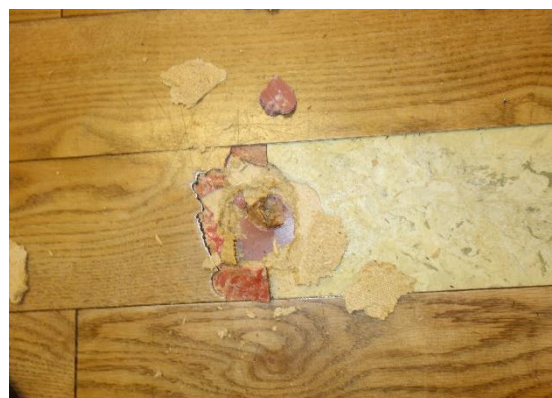
Figur 27. Exempel på lagerföljd av ytskikt på bottenplan (prov 29). Ny PVC, beige/röd marmorerad plattmatta, masonit, röd/grå strimmig plattmatta (prov 26), masonit, träbjälklag. Inget lager innehåller asbest.
