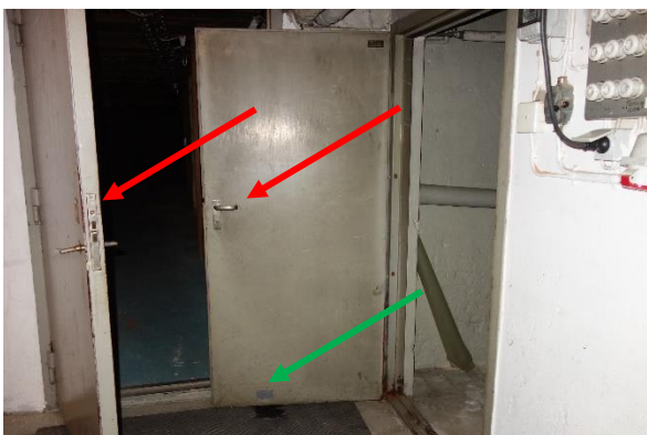
Figur 16. Äldre branddörrar i källaren med asbest i låskistan. Prov 25 (grön pil) isolering branddörr, innehåller inte asbest.
