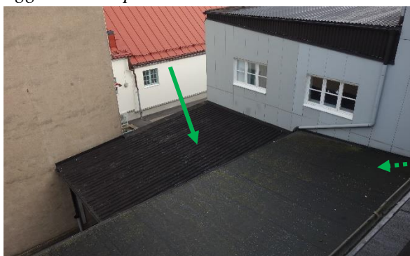
Figur 8. Svart beläggning på TRP plåt innehåller inte asbest (prov 19, grön pil).
