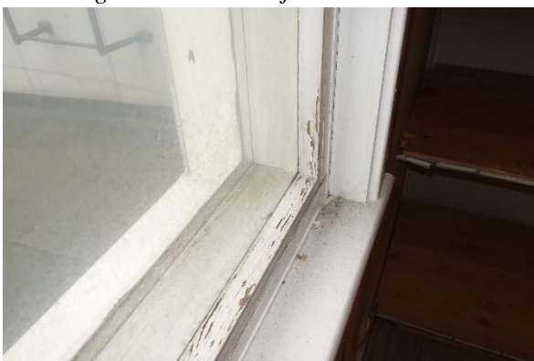
Figur 20. Exempel på förekommande 2-glasfönster utan fönsterkitt.
