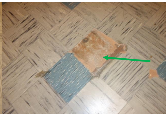
Figur 25. Blå/grå strimmig plattmatta med ljust lim på masonit på plan 2 (prov 11). Varken matta eller lim innehåller asbest.
