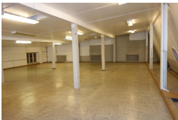
Figur 12. Stomme och golvbjälklag av trä.
