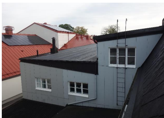
Figur 7. Takdelarna ligger i olika nivåer, de flesta ser ut att vara belagda med TRP-plåt.
