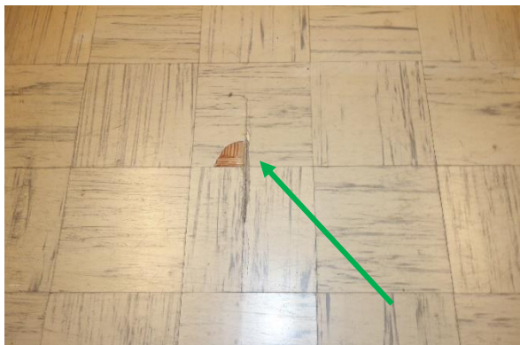
Figur 24. Gråstrimmig plattmatta med ljust lim på masonit på vindsplan (prov 10, ej asbest).
