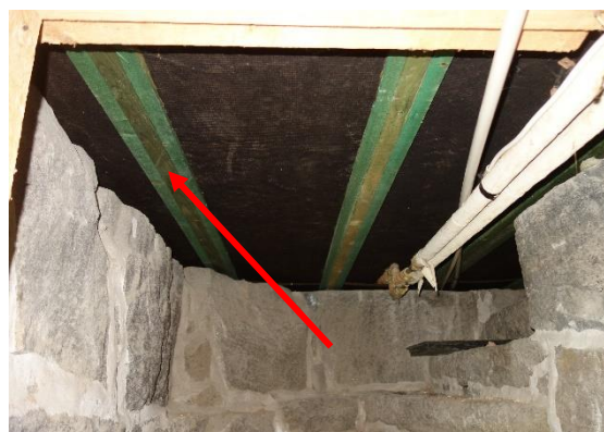
Figur 13. Cuprinolmålade regler i bottenbjälklag i del från 1970-talet.
