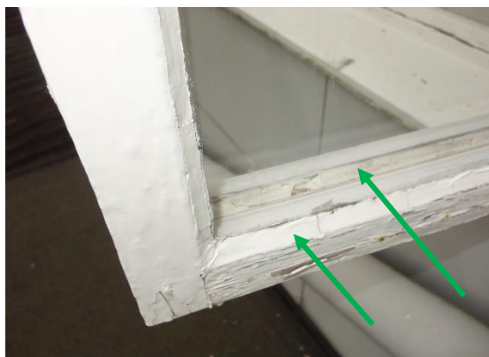
Figur 19. Exempel på provtaget utvändigt och mellanliggande fönsterkitt utan asbest.
