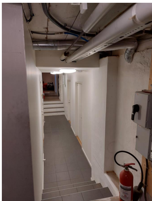
Bild 6. Tak i korridor, råspont i trä samt vissa delar gipsklädd.
