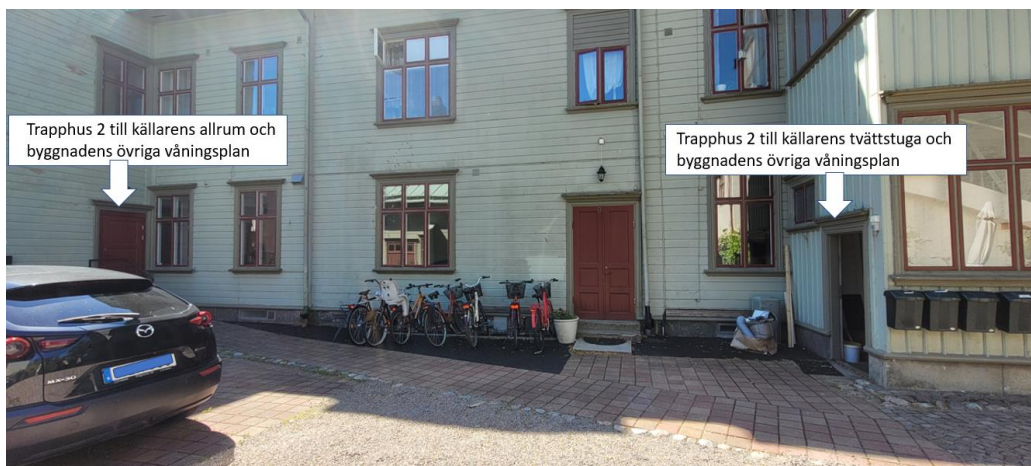
Bild 3 från innergården påvisar mycket små fönster i källaren.
