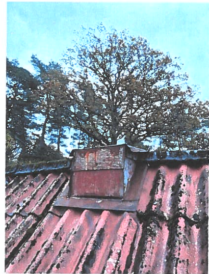
Figur 1. Rester av plåtskoning
