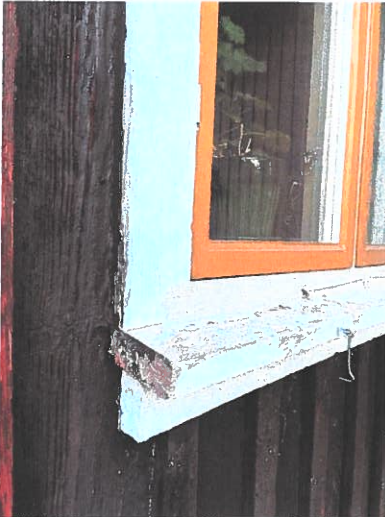
Figur 2. Äldre konstruktion dropp-list
