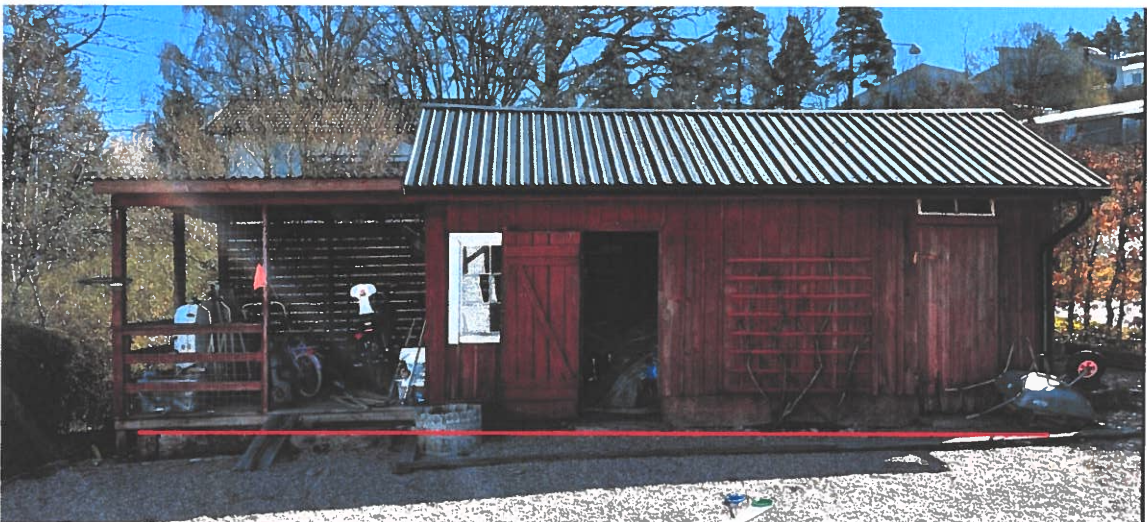
Figur 2: Innan rivning (2021-04-30). Till vänster ser man att en del sedan tidigare är riven och ersatt med ett plåttak och trallgolv (där cyklarna står). Till höger om byggnaden, bakom skottkärran är en ungefär lika stor del också riven sedan tidigare (delvis utanför bild). Där är bara stengrund kvar. Dessa delar revs för 15-30 år sedan är vår gissning. (Vi flyttade in 2011.) Röd linje visar på ett ungefär vilken nivå överkant stengrund ligger under byggnaden. Med åren hade kringliggande mark höjts varför befintligt grund var för låg för att kunna bygga på. Detta gjorde att syllarna delvis hade legat under marknivå och därmed blivit rötskadade. I synnerhet var detta ett problem åt öster.
