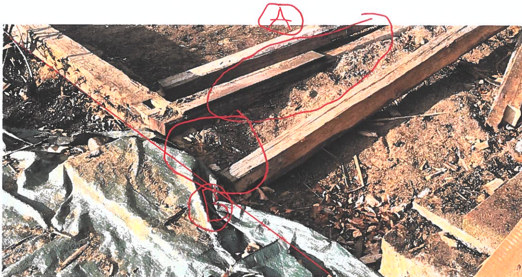
Figur 3: Bilden är tagen under rivning vid den högra dörren på figur 2. A) Den enda kvarvarande tvärgående golvregeln ligger mestadels under jord och är följaktligen i väldigt dåligt skick. B) Syll ytterkant åt väster som vid inringat område ligger helt under marknivå. Till höger om ringen finns inget kvar av syllen.
