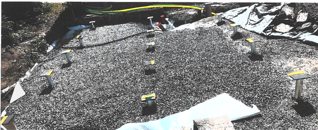
Figur 7: Efter att inhämtat råd beslutade vi att plintgrund var mest lämpligt. Vi fick också rådet att ta bort gammal stengrund på sidorna för att kunna gräva in VA och för att kunna komma åt undertill. På bilden syns att huset nu står över en makadambädd och att marken är upphöjd 30-40 cm i vänsterkant relativt innan.
