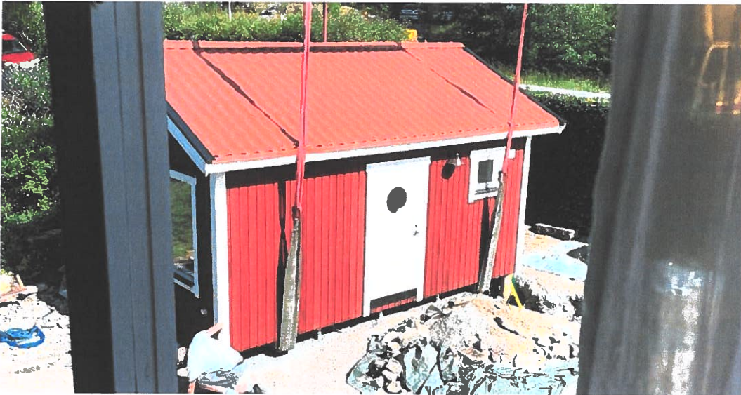
Figur 8: 2021-06-28 lyftes ett färdigt hus på plats.
