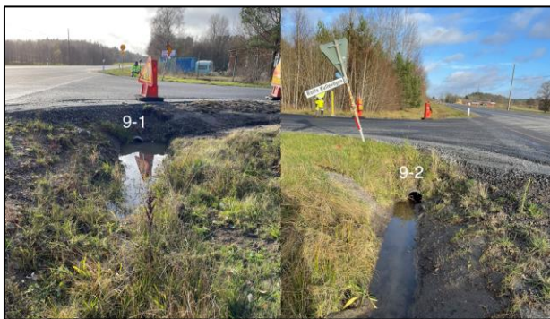
Figur 14. Dagvattentrumma som ansluter delområdet i öst till nedströms. Maxkapacitet 100 l/s.
