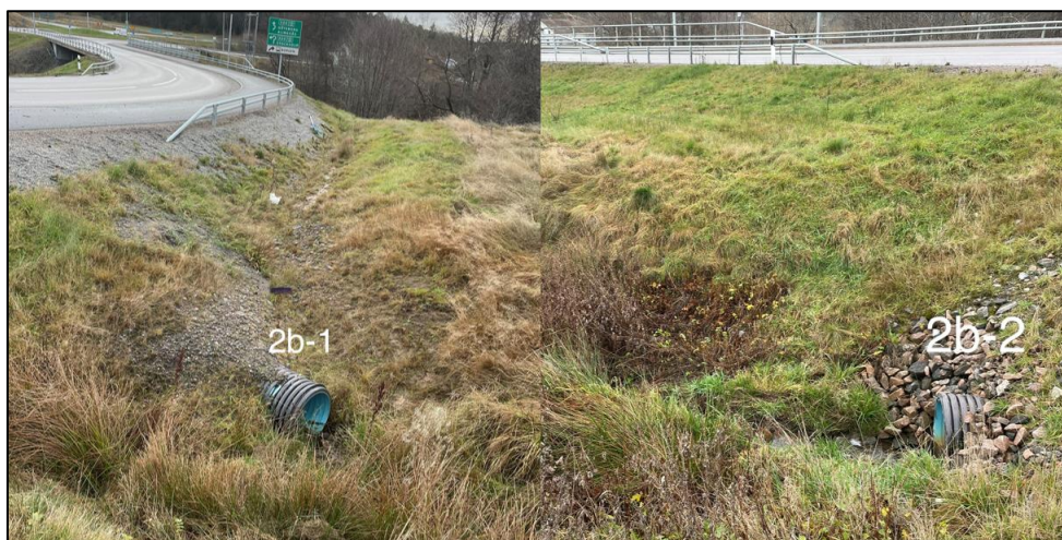
Figur 18. Trumman under Stockholmsvägen, öster om befintlig cirkulationsplats. Maxkapacitet 600 l/s.
