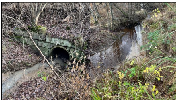
Figur 14. Dagvattentrumma som ansluter delområdet i öst till nedströms. Maxkapacitet 100 l/s.
