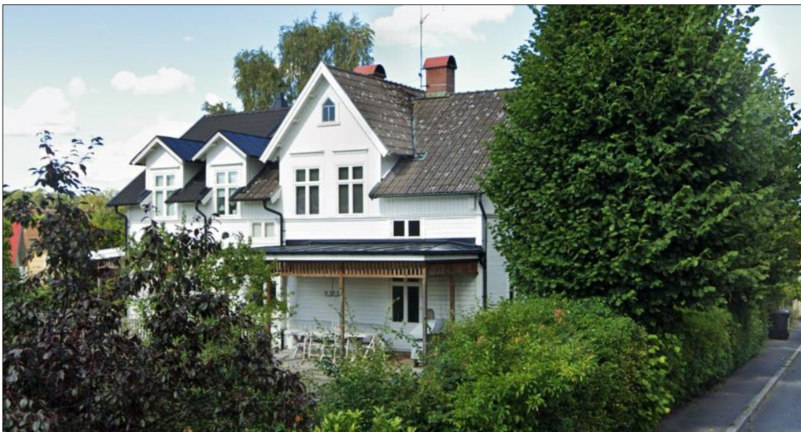
Figur 5 En liknande villa på andra sidan gatan i samma stil, men varierat utförande. Här syns den växelvis stående och liggande panelen på fasaden, där dock varje våning har växelvis stående eller liggande panel utöver den stående panelen vid sockeln.
