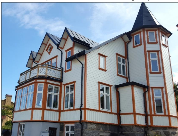
Figur 2 Panelen är typiskt indelad med panelavdelande listverk i avvikande, mörkare kulör i samma nyans som fönsteromfattningarna, dock brukade fönsterbågarna vara en nyans mörkare. Den nedre panelen är stående, vilket var vanligt. Här syns även det karaktäristiska tornet, liksom det balkongförsedda burspråket och de extra gavelpartierna på frontespisen som bryter igenom långsidans takfall.
