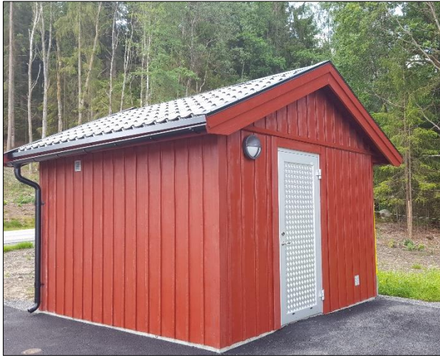
Figur 5-6 Byggnaden ovan visar en nätstation/transformatorstation som i sin mer detaljerade utformning är bättre anpassad inom och intill kulturmiljöer. Fotot till vänster av Linda Lökvist, fotot till höger urklipp ur fotomontage i ärendet.
