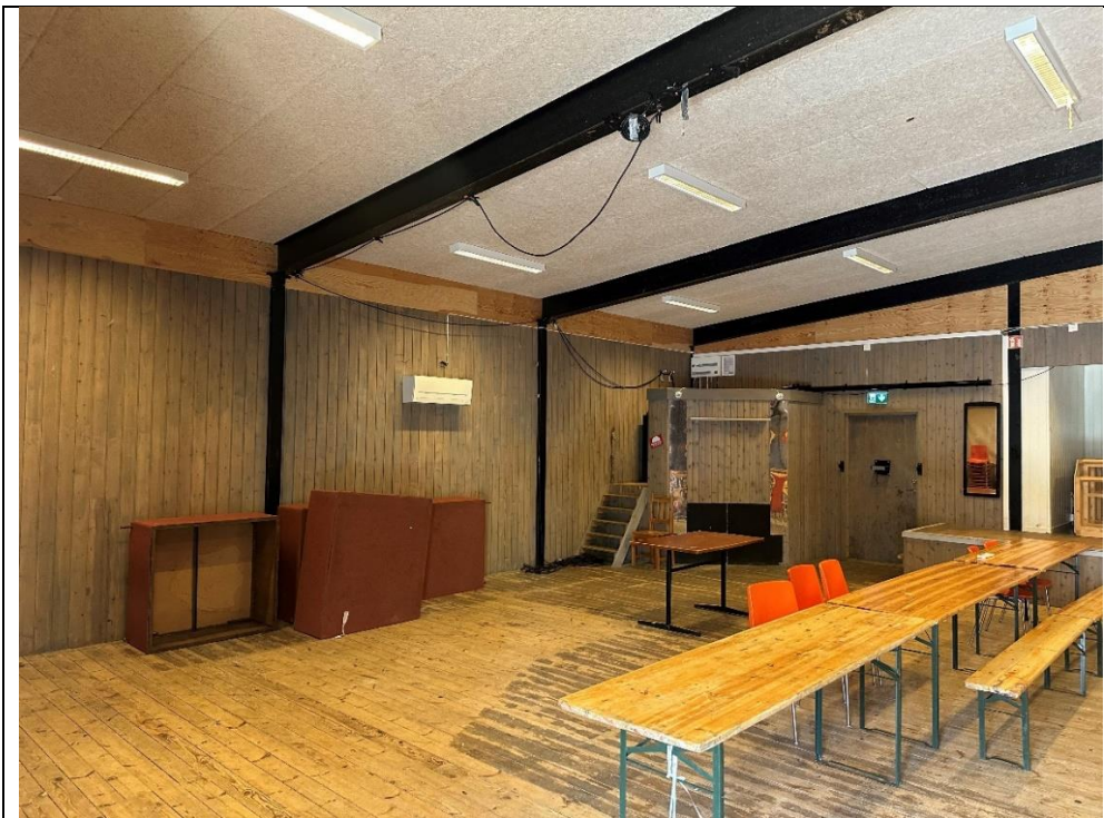
Bild 1: Armaturer, väggguttar, diverse el demonteras innan rivning, lysrör/ljuskällor demonteras från armaturer och skickas som material innehållande kvicksilver. Samtlig avfall klassas som FA.
