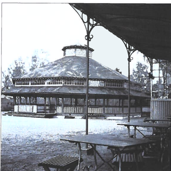
Figur 14 Dansrotundan var ursprungligen också öppen och hade fönster hela vägen runt om i mellanrummet mellan takfallen.
