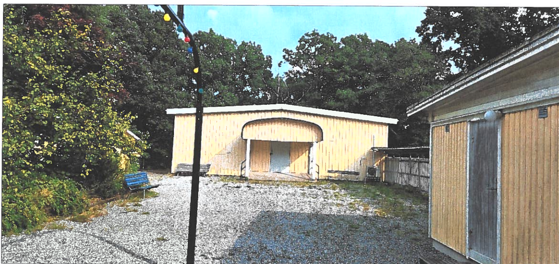
Figur 10 Gluggen är en enkel, i grunden rektangulär byggnad med tillbyggnad baktill och en taköverbyggd entré.
