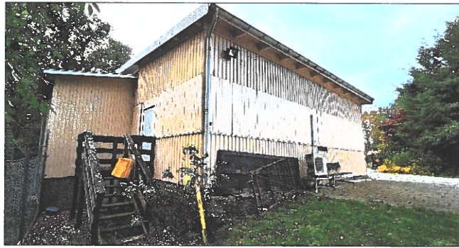
Figur 11 Byggnadens horisontella fönsterband, som löper längs hela fasaden runt om, har satts igen med smal träpanel. Foto: Linda Lökvist 2024-09-30.
