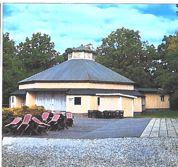
Figur 15 Även dansrotundan har byggts igen med väggar och den övre fönsterfasaden mellan taken, som skulle tillföra ljus har fått slät träpanel.
