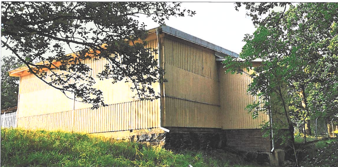
Figur 12 Mellanpartiet av 'Gluggen' var antingen helt öppet eller hade öppningsbara luckor, idag är detta helt igenbommat. Stengrunden är dock gammal och vittnar om den äldre, öppna dansbanan som sannolikt byggdes 1915 eller strax efter. Man började inte med betonggrund förrän någon gång på 1930-talet. Uppförandet av en byggnad för dansbanan har gjorts omkring 1960-talet. Dock fanns den lilla utbyggnaden redan åtminstone 1947 (se figur 9). Grunden för tillbyggnaden, som ursprungligen byggts till som scen till den första dansbanan, består av betong, så den bör rimligtvis ha uppförts mellan ca 1930 och 1947. Foto: Linda Lökvist, 2024.08.29.
