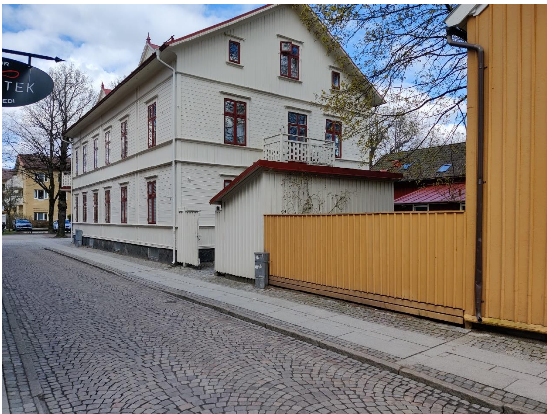
Fastigheten Korpen 1, Torggatan 2. Fasader mot sydväst.
