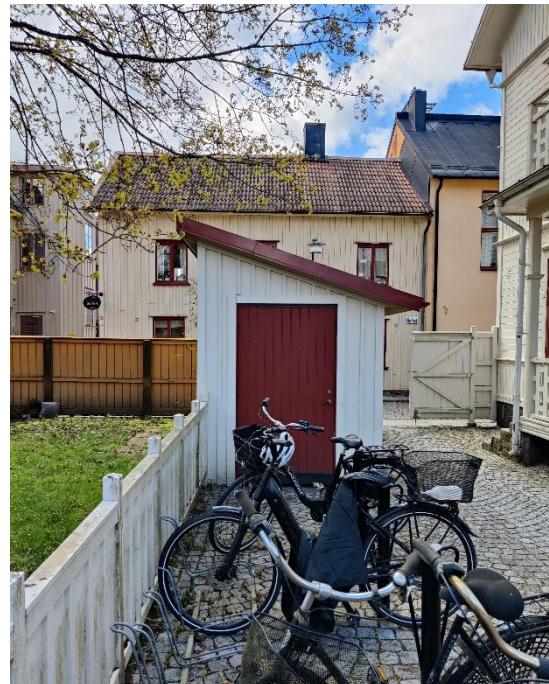
Fasad mot öster, dörren tas bort och flyttas till norra fasaden.
