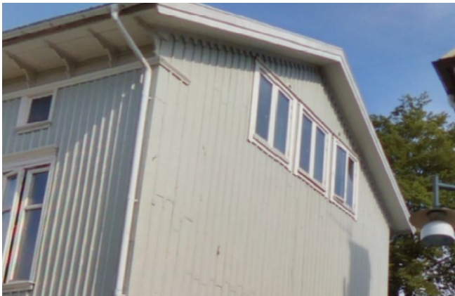
Östra fasaden 2014-07-27. Sidohängda 2-luftsfnster. Utåtgående i trä.
