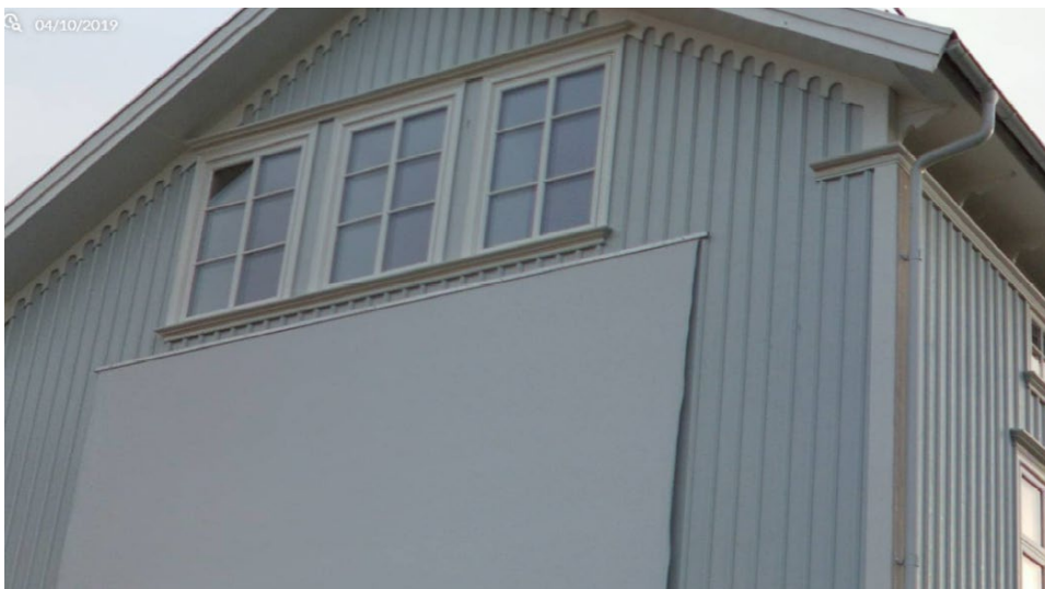
Västra fasaden 2019-10-04. Helt fönster med 6 lufter totalt.
