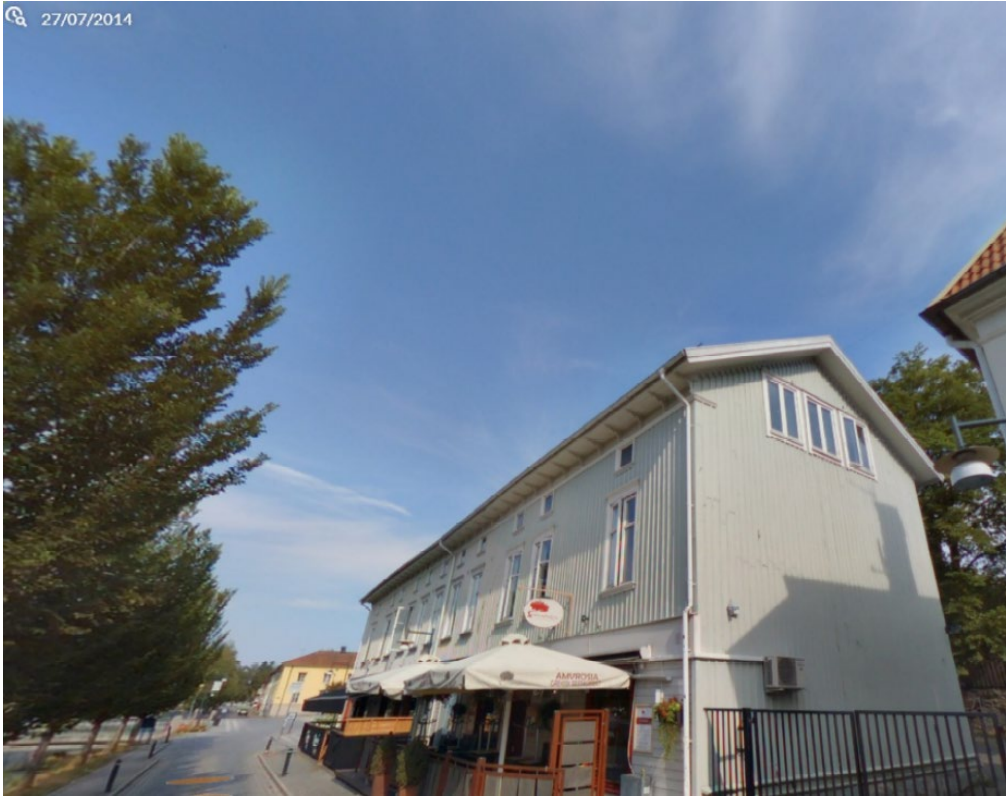
Östra fasaden 2014-07-27. Sidohängda 2-luftsfnster. Utåtgående i trä.
