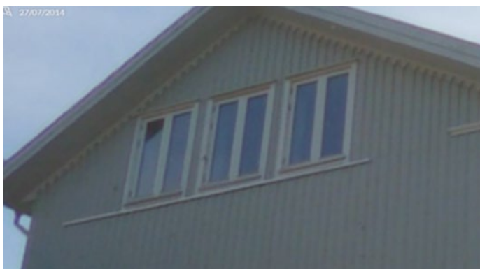
Västra fasaden 2014-07-27. Sidohängda 2-luftsfönster. Utåtgående träfönster.
