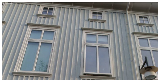
Korspröjs , pivoupphängning, aluminium utsida.
