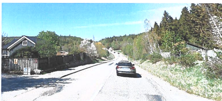
Sikt åt höger från anslutning som ska ändras, väg 180.
