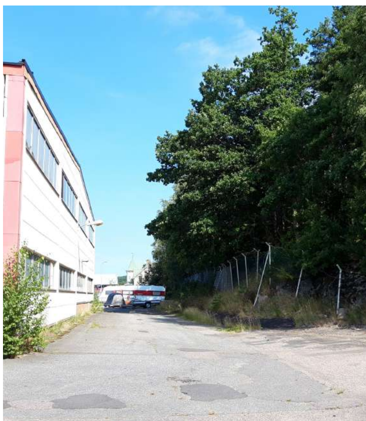
Figur 22 - Bilden visar befintlig byggnad intill fastighetsgränsen åt öster samt kanten på Hjortmarka naturreservat som gränsar till planområdet.
