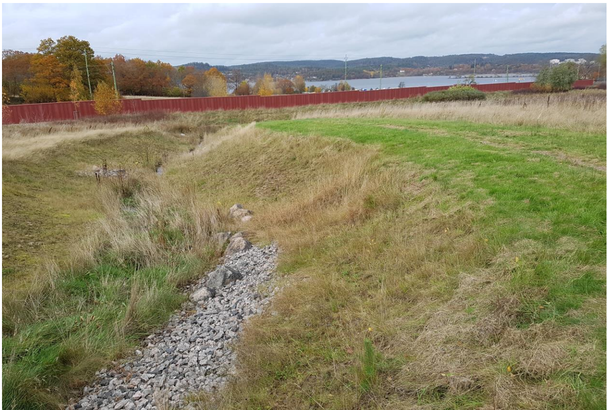
Bild 2. Ett system av dammar har nyligen anlagts för att ta hand om dagvatten från Stadsskogen (naturvärdesobjekt 3).
