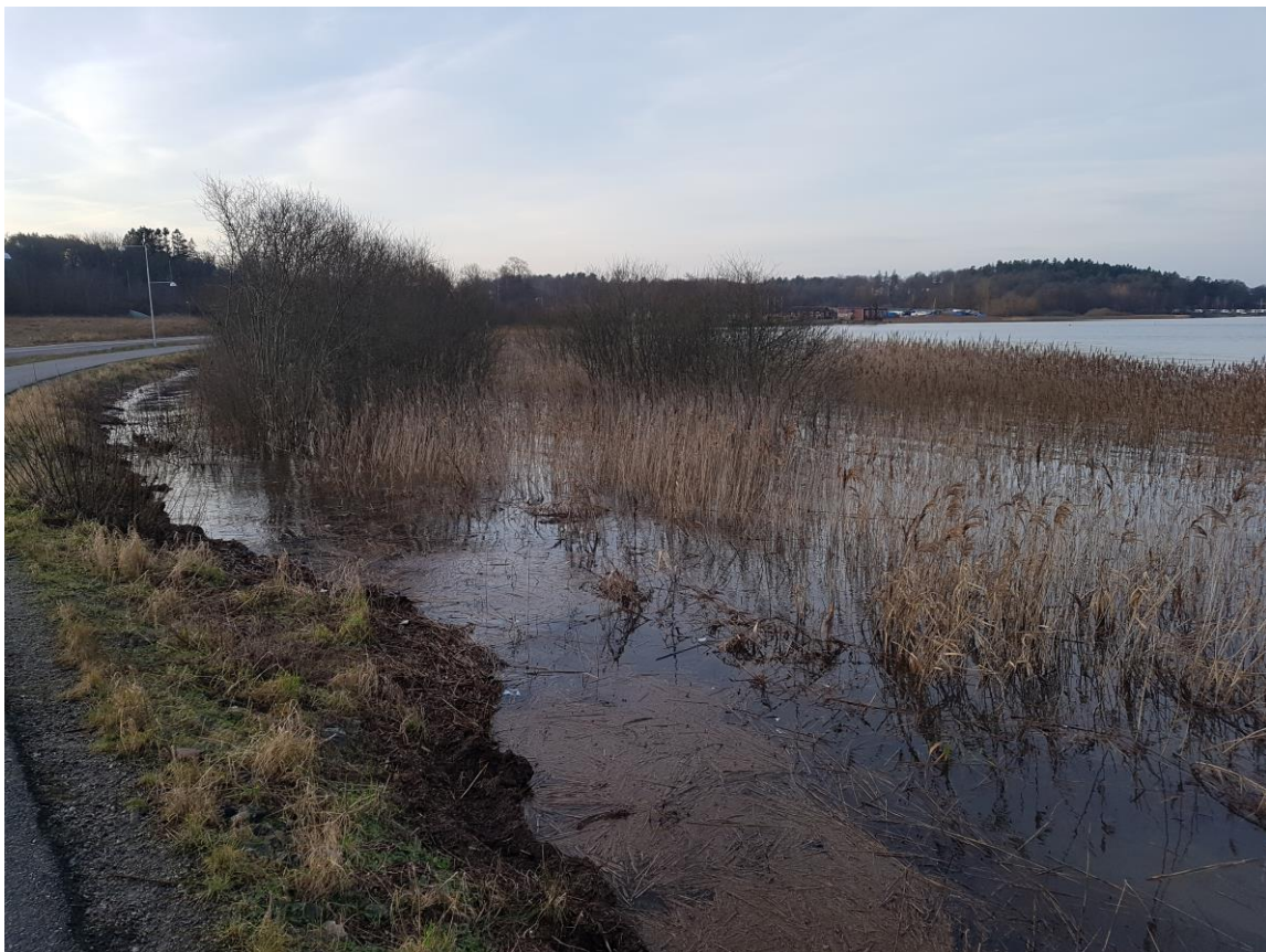
Bild 4. Cykelbanans vägbank utgör strandlinje vid södra Bollplansstranden (objekt 10).
