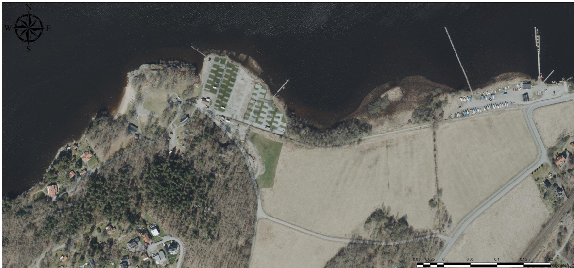
Flygfoto från 2022 under pågående anläggningsarbete.. Källa: Alingsås kommuns historiska flygfoton i GIS-kartorna.
