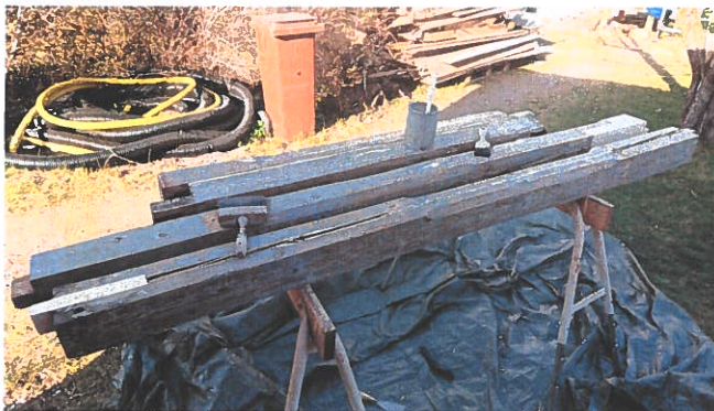
Förstukvistens stolpar lagas. Gammal färg tas bort, och ommålning sker
