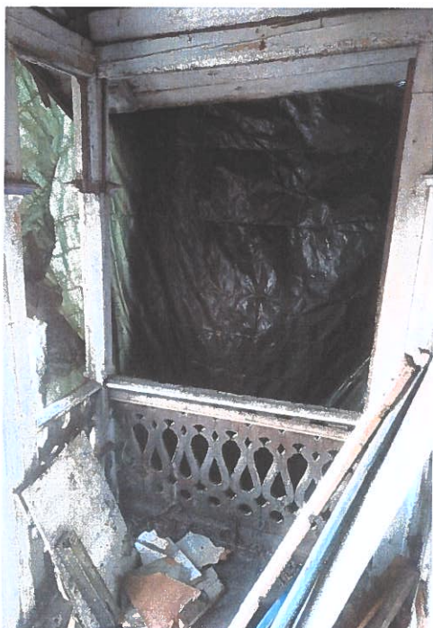
Förstukvisten före demonteringen
