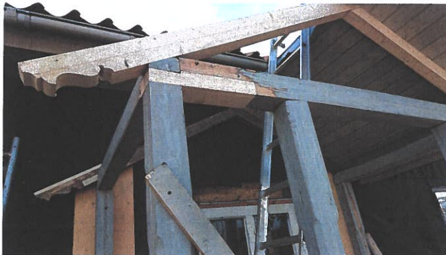
Den bakre konsolen lagas och utgör också en mall för den främre som fick bytas ut.
