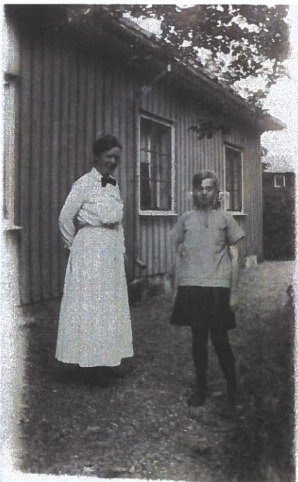
Äldre foto på den östra, tillbyggda, delen av huset med Stampens kvarn i bakgrunden. Det framgår att fönsterfoder endast målats på panelbrädorna och att fönsterbågarna var målade i mörk färg. Årtal okänt.
