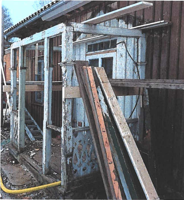
Förstukvisten under demontering
