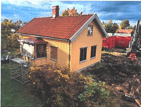
Huset sett från sydost. Verandan på plats igen, fönsterarbeten återstår. Rivning av tillbyggnad enligt beviljat rivningslov pågår till höger i bild.
