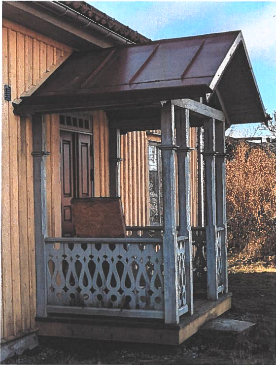
Förstukvisten efter återmontering, endast en enda stolpe är utbytt.
