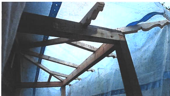
Återmontering av verandans tak. Konsolerna har samma profil som innan.
