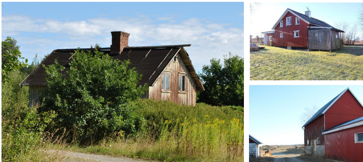
Figur 32. Det förfallna bostadshuset av Bengtsgården till vänster och gårdsbebyggelsen vid Rolfs kulle till höger.
