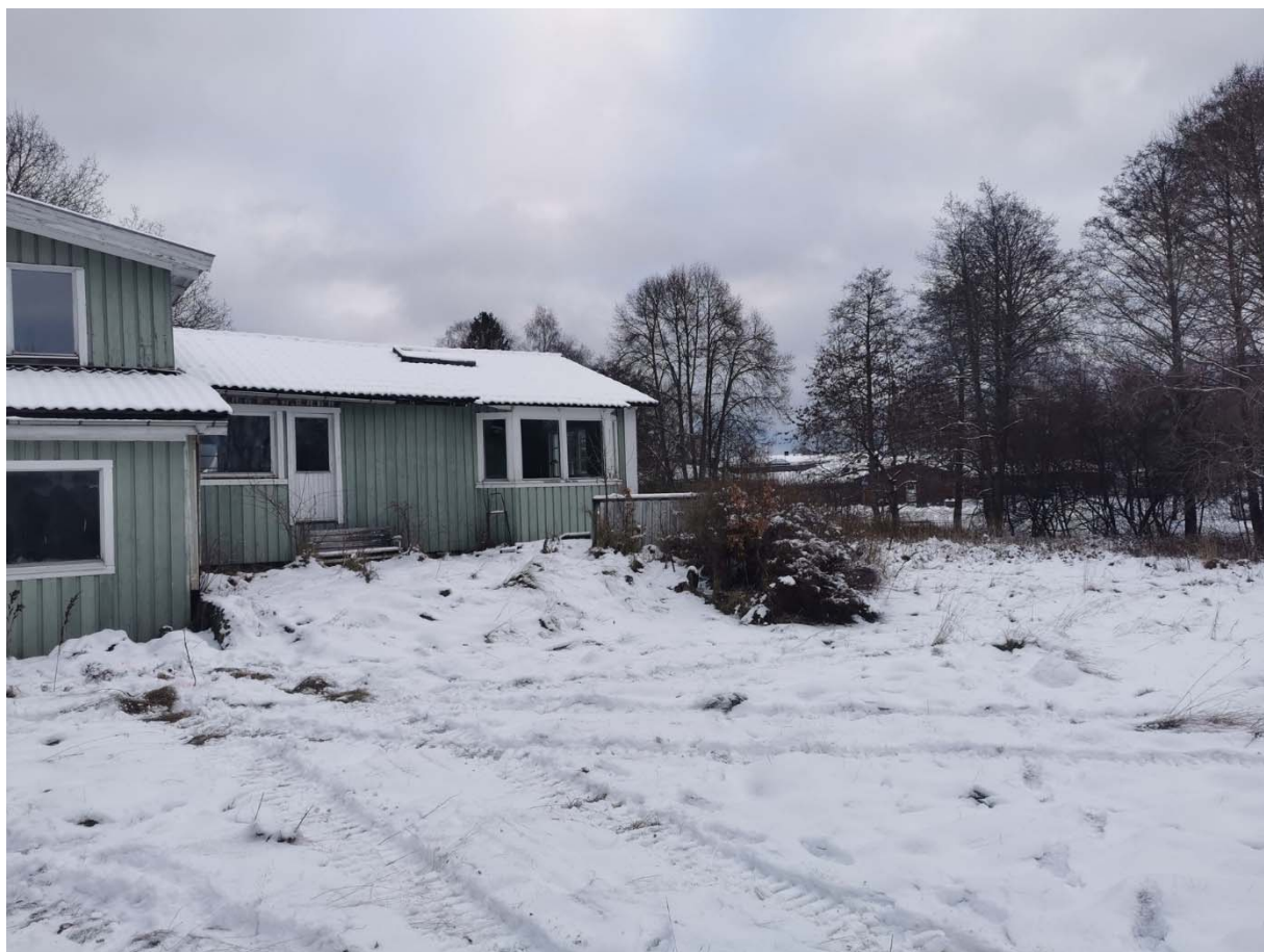
Bild 2. Bilden visar den undersökta tomten och delar av den befintliga byggnationen.
