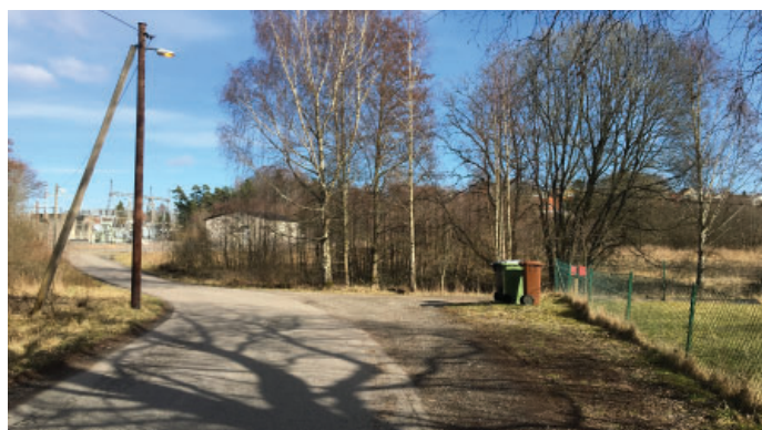
Alfhemsvägen i höjd med de befintliga bostäderna inom planområdet, den plats där den nya Genomfartsgatan kommer att ansluta till Ekhagegatan. I bakgrunden syns Vattenfalls ställverk
