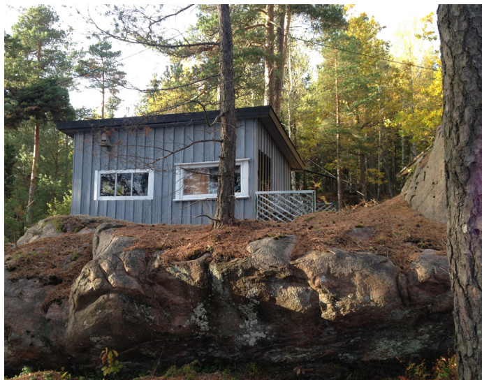
Komplementbyggnad i Saxebäcken
