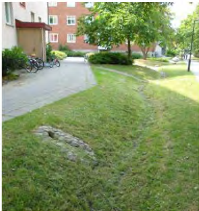
Figur 13: Exempel på Svackdike. Källa: RG dagvattenhandbok.
