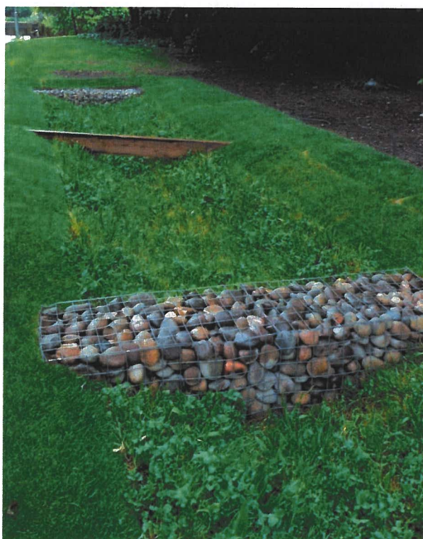
Figur 7.5 Ett svackdike med dämmen av gabion och trä.
