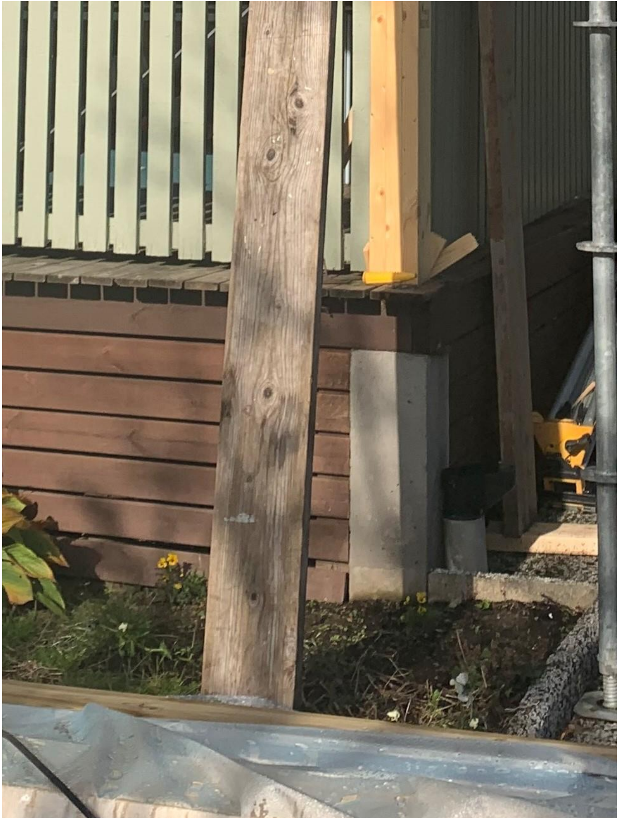
Figur 5. Pelarens grund är i betong
