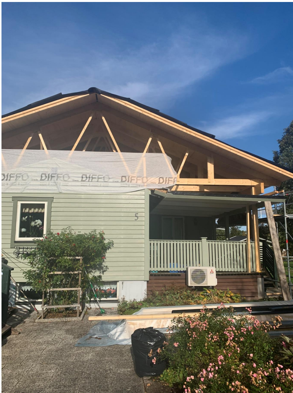
Figur 1. Ny takkonstruktionen
