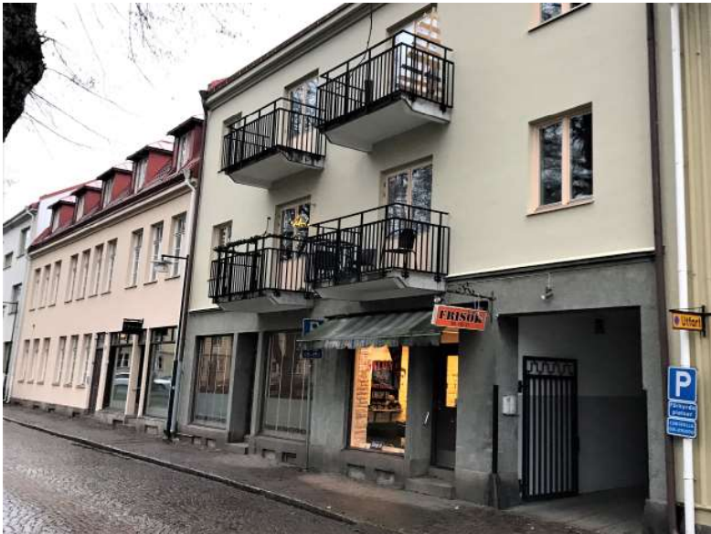
Putshus med bottenvåning, inklusive portgång, klädd med natursten ut mot gatan. Byggnaden är även försedd med utanpåliggande balkonger med genomsiktliga och sakligt utformade räcken i mörkmålat och smäckert smide.
