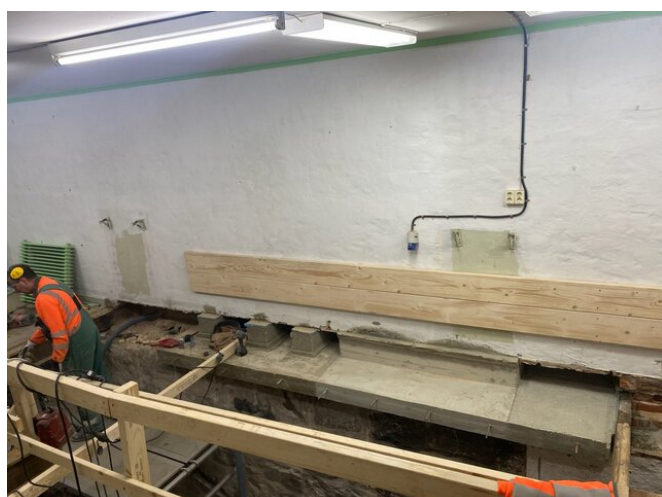
Gjutning över väggkonstruktion.
