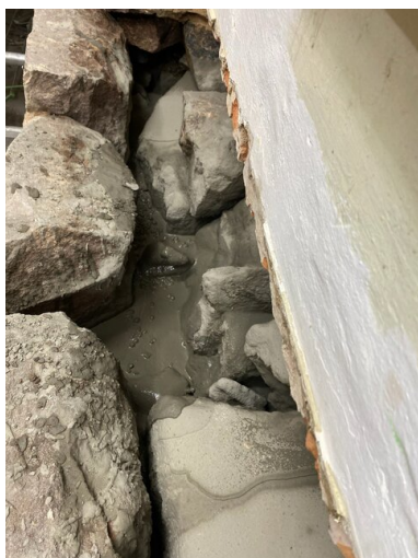
Efter lem har alla håligheter fyllts med flytspackel
