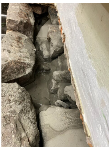
Naturstens vägg fylld med kem och flytspackel.
