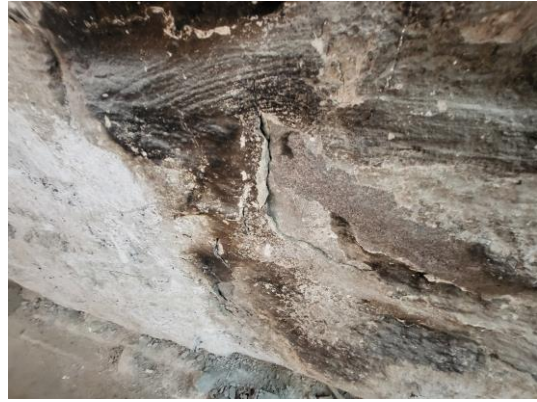
Bild 10 MP 7: Murbruk runt granitsten.
