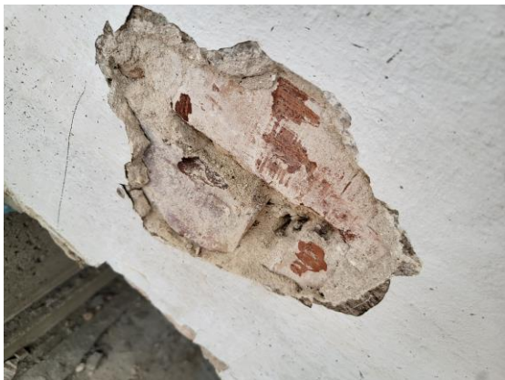
Bild 19 MP 11: Murbruk/puts, fastighetsetsskiljande vägg av tegel.
