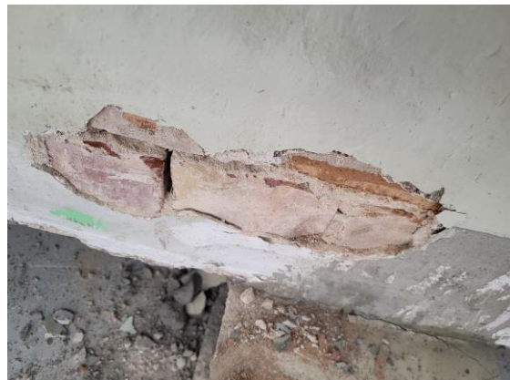
Bild 20 MP 12: Murbruk/puts, fastighetsetsskiljande vägg av tegel.
