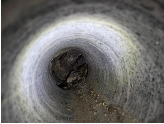
Bild 9 MP 6: Grundmur granit/mark.
