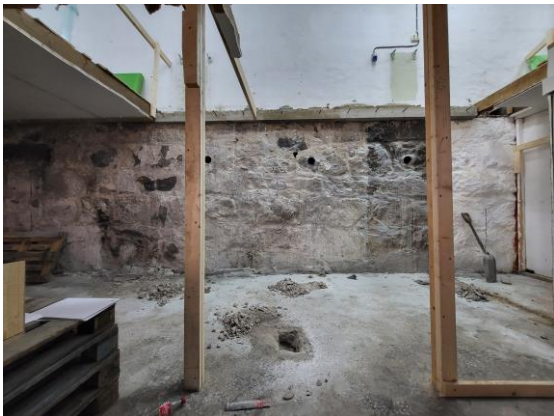
Bild 3 Bild mot fastighetsskiljande vägg med grundmur. I detta område har äkta hussvamp konstaterats i träbjälklaget mot fastighetsskiljande vägg.
