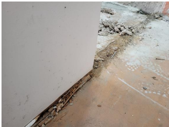
Bild 11 MP 8: Fotlist trä ner mot golv.
