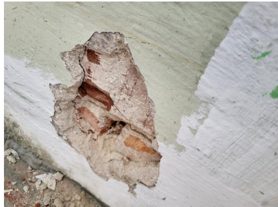
Bild 18 MP 10: Murbruk/puts, fastighetsetsskiljande vägg av tegel.
